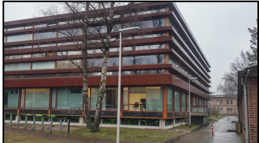
Een van de kantoorgebouwen op het kazerneterrein (gebouw 90)
