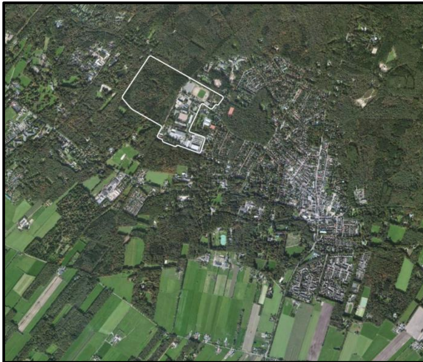
Luchtfoto Kampen- en overgangsgebied bij Doorn Bron: Urhahn, 2015
