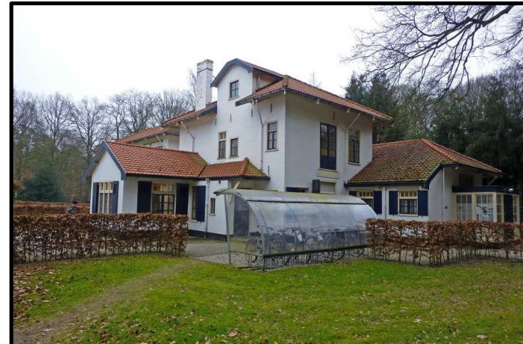
De karakteristieke commandantsvilla op het kazerneterrein (gebouw 41) Bron: Urhahn, 2015
