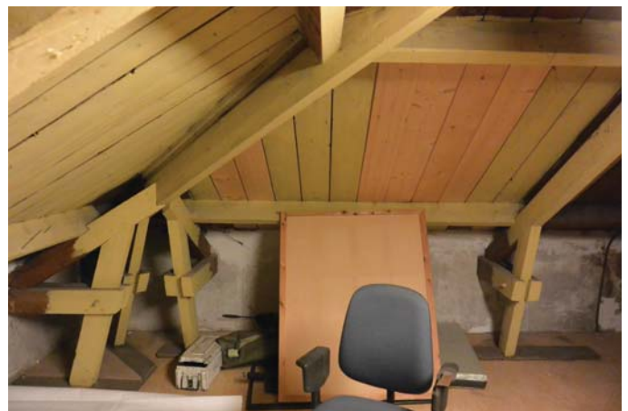
250. De kapconstructie van de oude villa, foto 2016.
