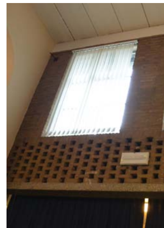
180. De betonspanten met siermetselwerk erboven in de eetzaal, foto's 2016.
