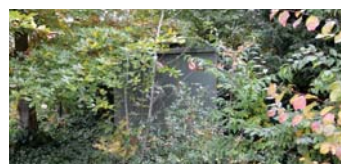
310. Gebouw 066 en 082, foto's 2016.
