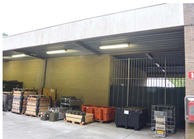
279. Zuidgevel gebouw 078, foto 2016.
