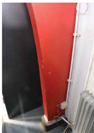
206. Gelamineerde houten spanten in gebouw 024, foto's 2016.
