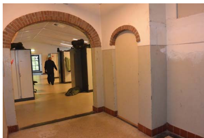
208. Sanitaire ruimte met terrazzo vloer en betonemaille wanden, foto 2016.
