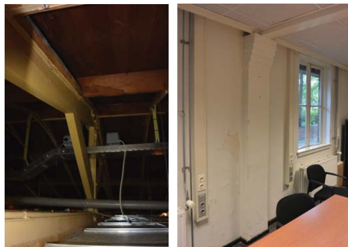
214. Constructie van vakwerkspanten op gemetselde penanten, foto's 2016
