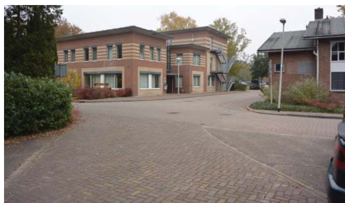
86. Voormalige hoofdweg met klinkerbestrating, op de achtergrond de voormalige entree tussen gebouw 001b (links) en 005 (rechts), foto 2016.
