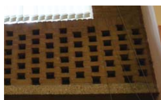
194. Siermetselwerk in gebouw 015 (links) en 018 (rechts), foto's 2016.
