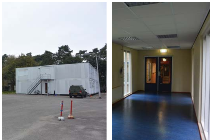
272. Zuidgevel (links) en verbindingsgang (rechts), foto's 2016.
