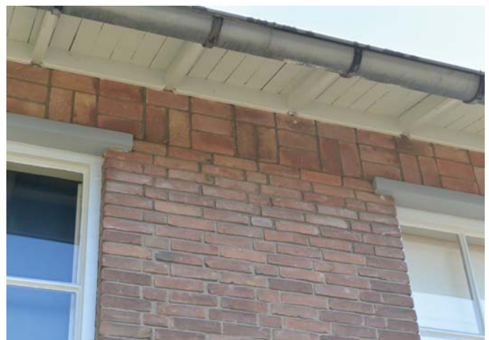
149. Detail van het metselwerk van de langzevel. Het metselwerk in breed kettingverband is goed zichtbaar, er zitten steeds vier in plaats van twee strekken tussen de koppen. Tevens is de band met kruislings tegelverband onder de dakgoot zichtbaar, deze band loopt tot de betonnen lateien boven de vensters. Foto 2016.
