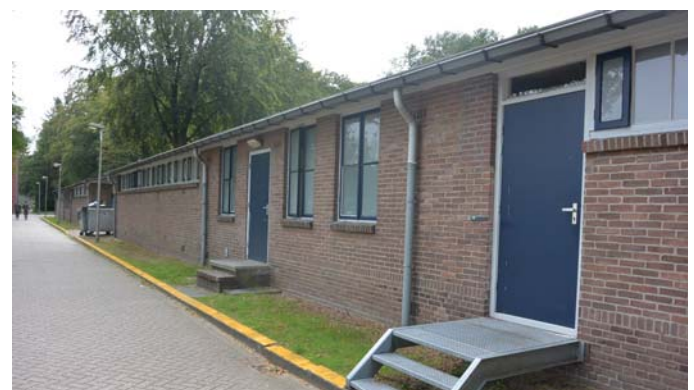
204. Gebouw 024 en 025 vanaf de exercitieplaats, foto 2016.
