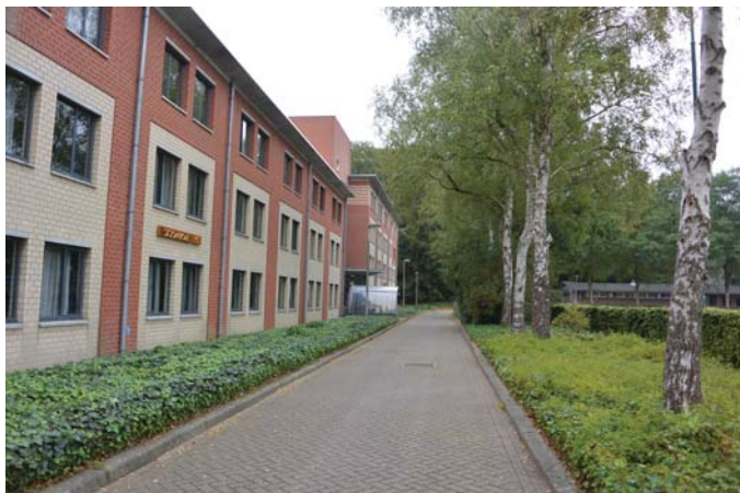
288. Gebouw 086 en 087 aan de exercitieplaats, foto 2016.
