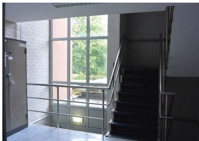
277. Gebouw 077 trappenhuis, foto 2016.
