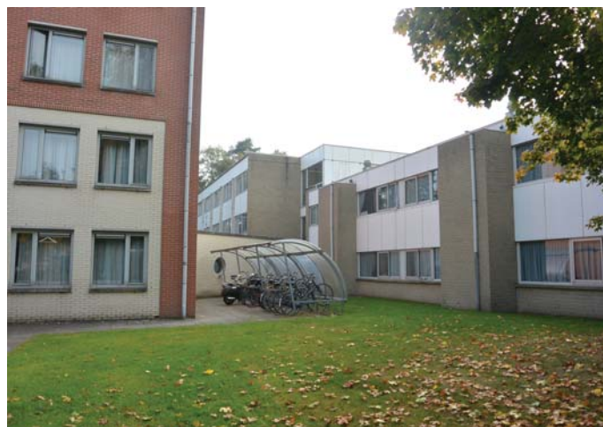
275. Gebouw 077 zuidwesthoek met verbindingsgang naar 009, foto 2016.
