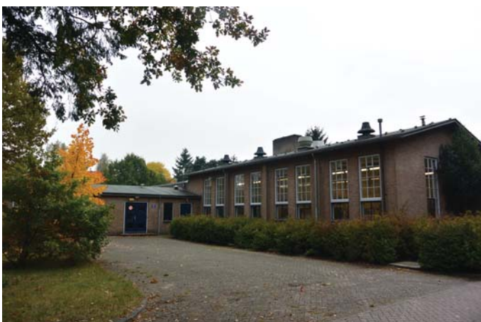
170. Hoofdvolume 2 vanuit het noordwesten, foto 2016.
