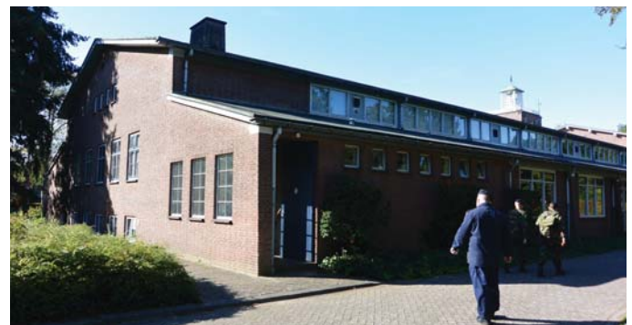
185. Gevels gebouw 018 vanuit het noordoosten, foto 2016.
