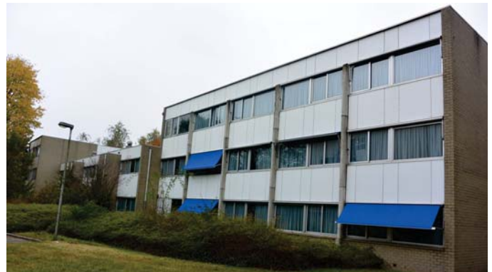
165. Gebouw 009 vanuit het zuidoosten, foto 2016. Op de voorgrond is een bouwdeel uit 1981 te zien met betonnen penanten tussen de ramen en op de achtergrond een bouwdeel uit 1976 met sanitairblokken i.p.v. penanten.
