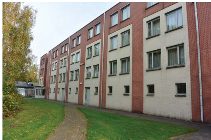
274. Gebouw 077 westgevel, foto 2016.
