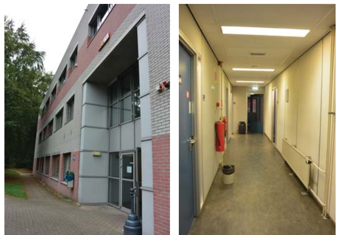
287. Entree in oostgevel en interieur gangen, foto's 2016.
