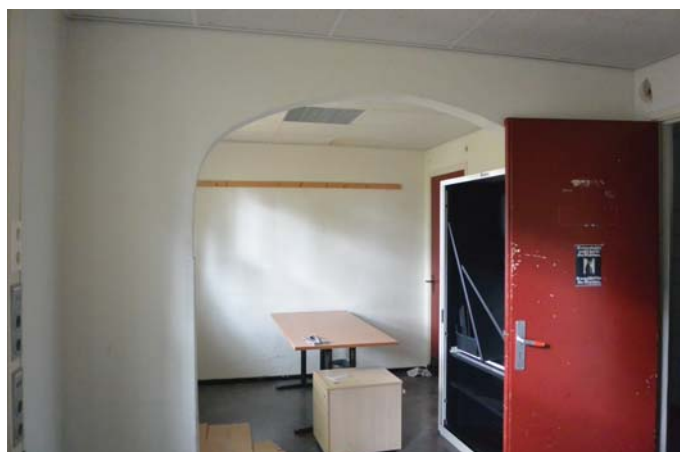
222. Dragende scheidingwand met boogvormige opening, foto 2016.
