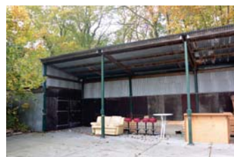
308. Gebouw 039A en 083, foto's 2016.
