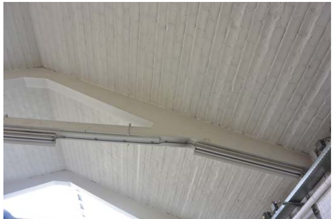
144. Gestort betonspant met Perfora dakstenen erover, foto 2016.
