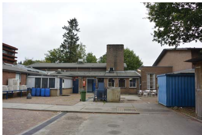
174. Vanuit het zuiden met links hoofdvolume 1 en rechts hoofdvolume 3.
