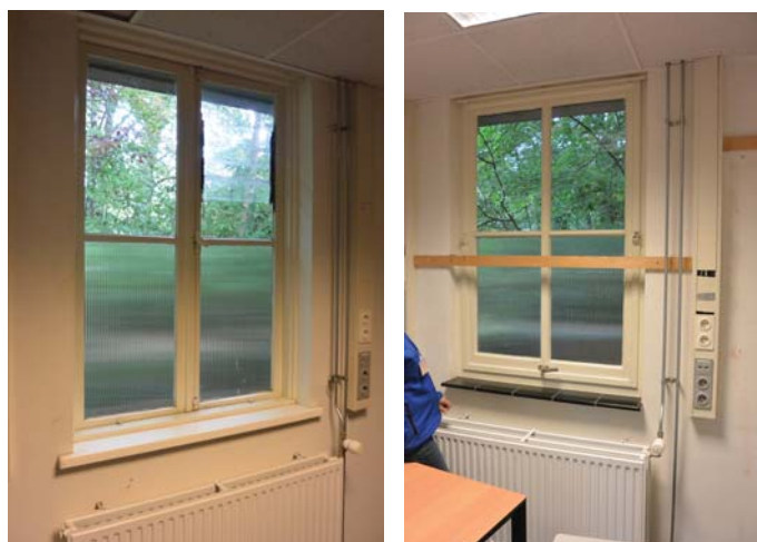
221. Venster in bestaand gebouw (links) en in uitbreiding (rechts), foto's 2016.
