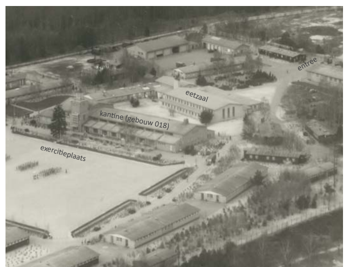
169. Luchtfoto van vlak na de oplevering in 1952, gebouw 015 vanuit het zuidoosten (Collectie Mariniersmuseum 48623). Op de voorgrond is de huidige exercitieplaats te zien met langs de noordzijde de kantine. Ten noorden daarvan is staat gebouw 015 met de eetzaal. In de rechter bovenhoek is de voormalige entree te zien.
