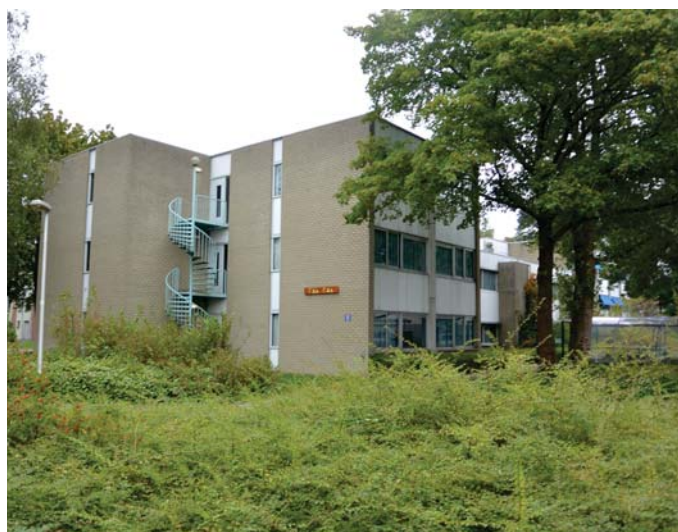
164. Gebouw 009 vanuit het zuidwesten, foto 2016.
