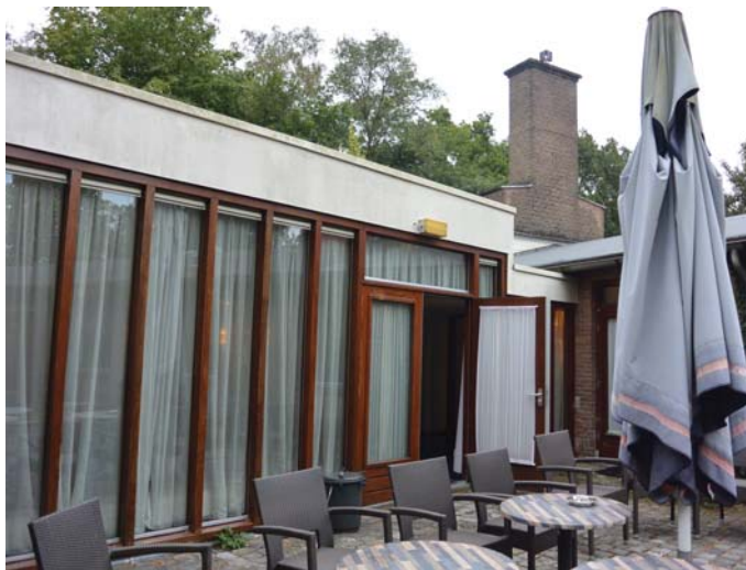
155. Aanbouw uit 1997, met op de achtergrond de schoorsteen, foto 2016.
