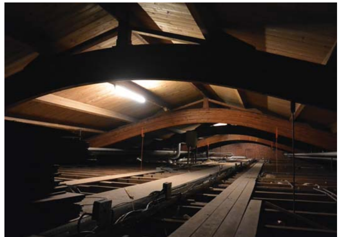
235. Gelamineerde spanten in zuidelijke deel, foto 2016.
