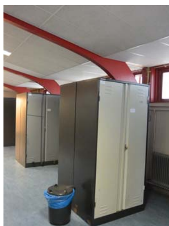
206. Gelamineerde houten spanten in gebouw 024, foto's 2016.
