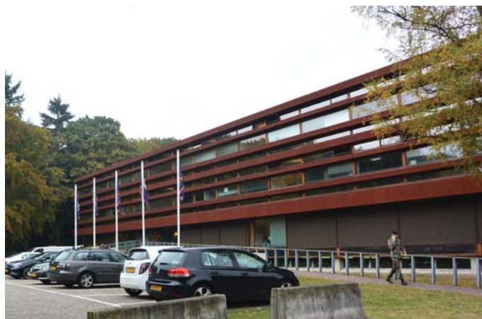
296. Zuidgevel gebouw 090, foto 2016.
