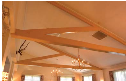
25. Groene groep: stenen barakken met houten vakwerkspant, foto's 2016.
