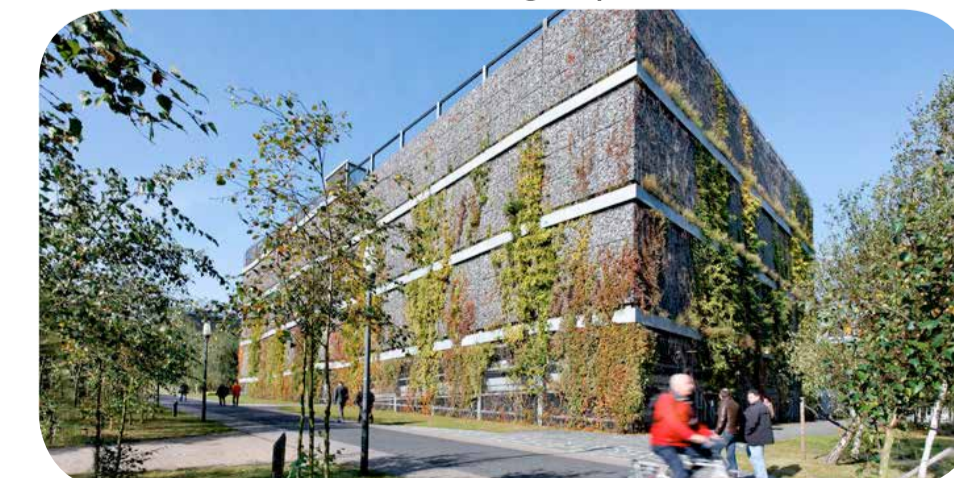
groene parkeervoorziening op de High Tech Campus in Eindhoven
